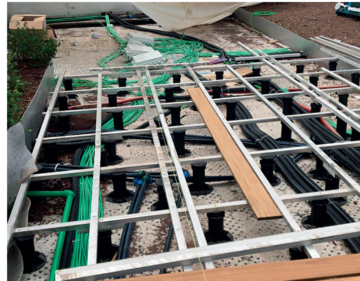
Connessione tra il pavimento galleggiante e il verde pensile.
